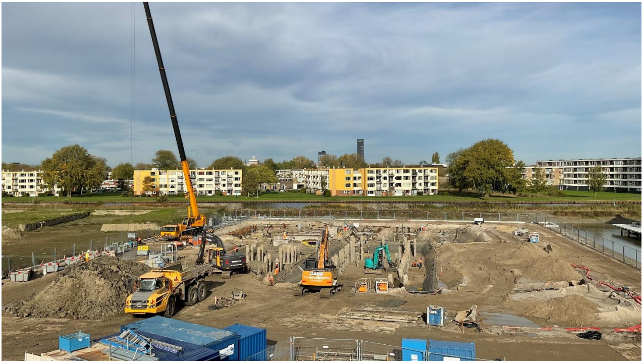
Het grondwerk wordt geprofileerd. De contouren van het gebouw worden zichtbaar.
